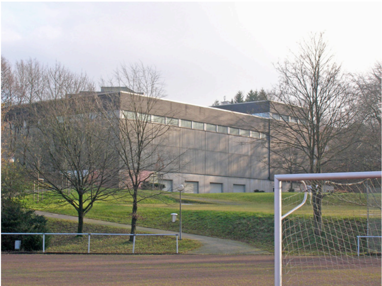
Die Schwimm- und Sporthalle der Bereitschaftspolizei beim Standort Müngstener Straße.
