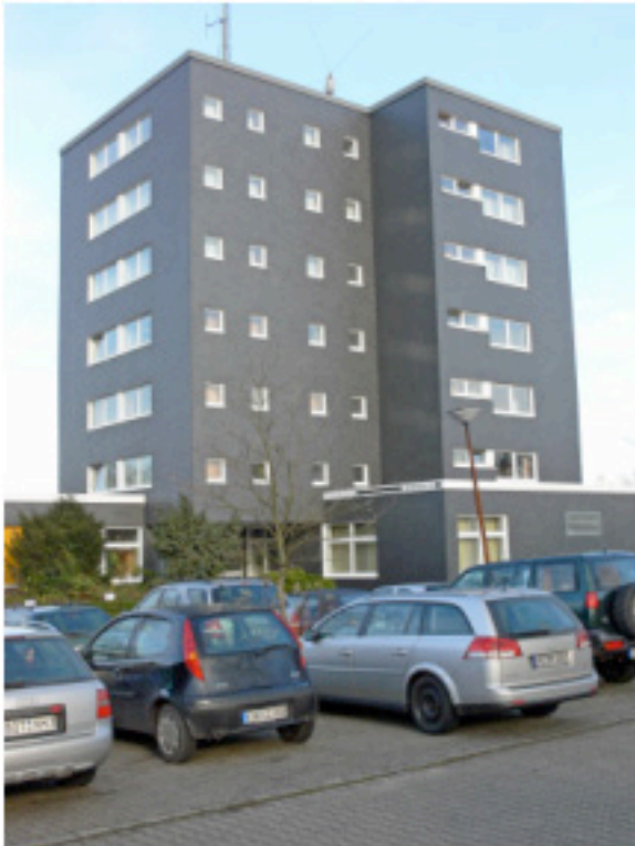
Das östliche Hochhaus ist eine Unterkunft für die Bereitschaftspolizei
